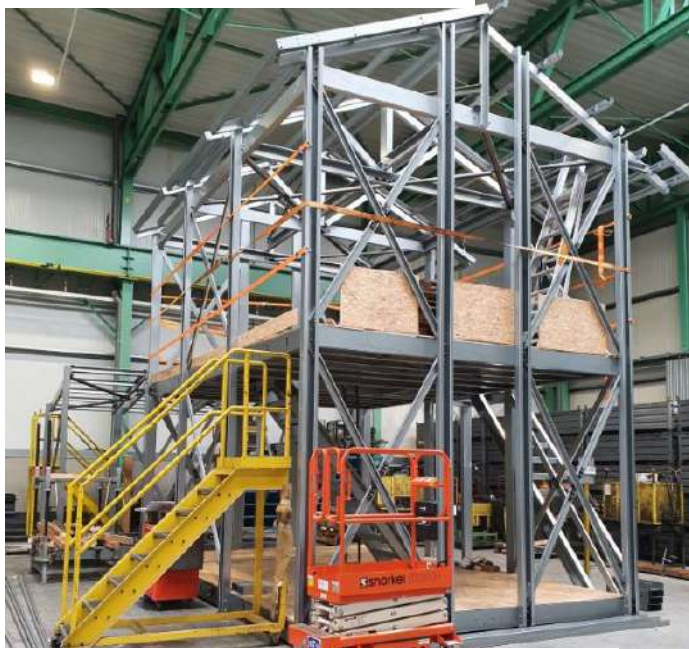
Prototype du logement de Majicavo monté en usine
