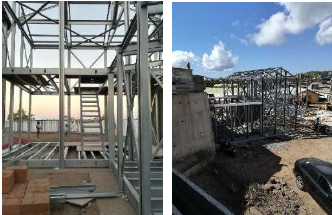
Photos du chantier en cours, septembre 2020
