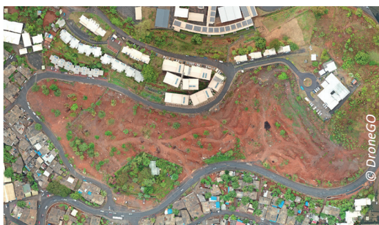
Après démolition - octobre 2021
