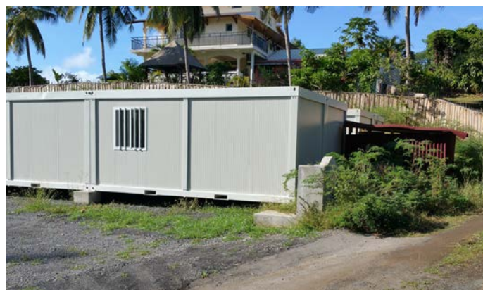
Logements temporaires modulaires à Hamachaka, village de Majicavo, Koungou-2016
