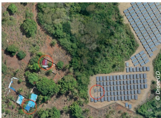
Parc photovoltaïque de Longoni avec panneaux manquants...
